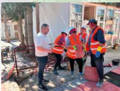
Obras de mejora en el cementerio
