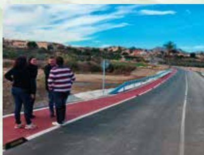
Obras en El largo y Grima
