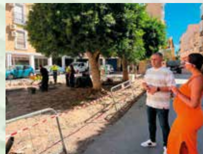
Obras de accesibilidad
